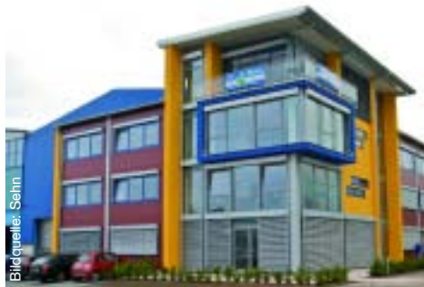
Näher dran: Seit Juli ist das Kanalbau-Team an seinem neuen Standort.
